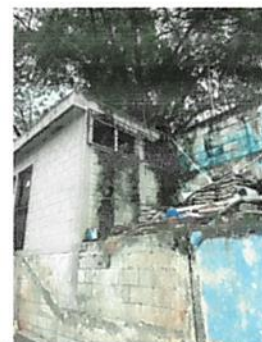
Foto 6: SUSTITUCIÓN DE VENTANAS
